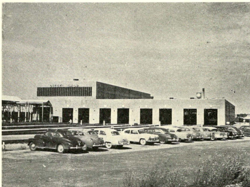
Remisen i Springfield med 9 spor. I det forhøjede parti findes en 30 t kran, der kan løfte alle større enkeltdele som dieselmotor, generator og banemotorbogie. Til venstre et halvtog over talje og kogeke, der kan tage hele bogierammer og hjulset.
