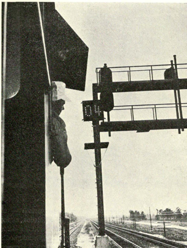
En elektrisk indikator meddeler lokomotivføreren hvilket spor toget ledes ind på.
